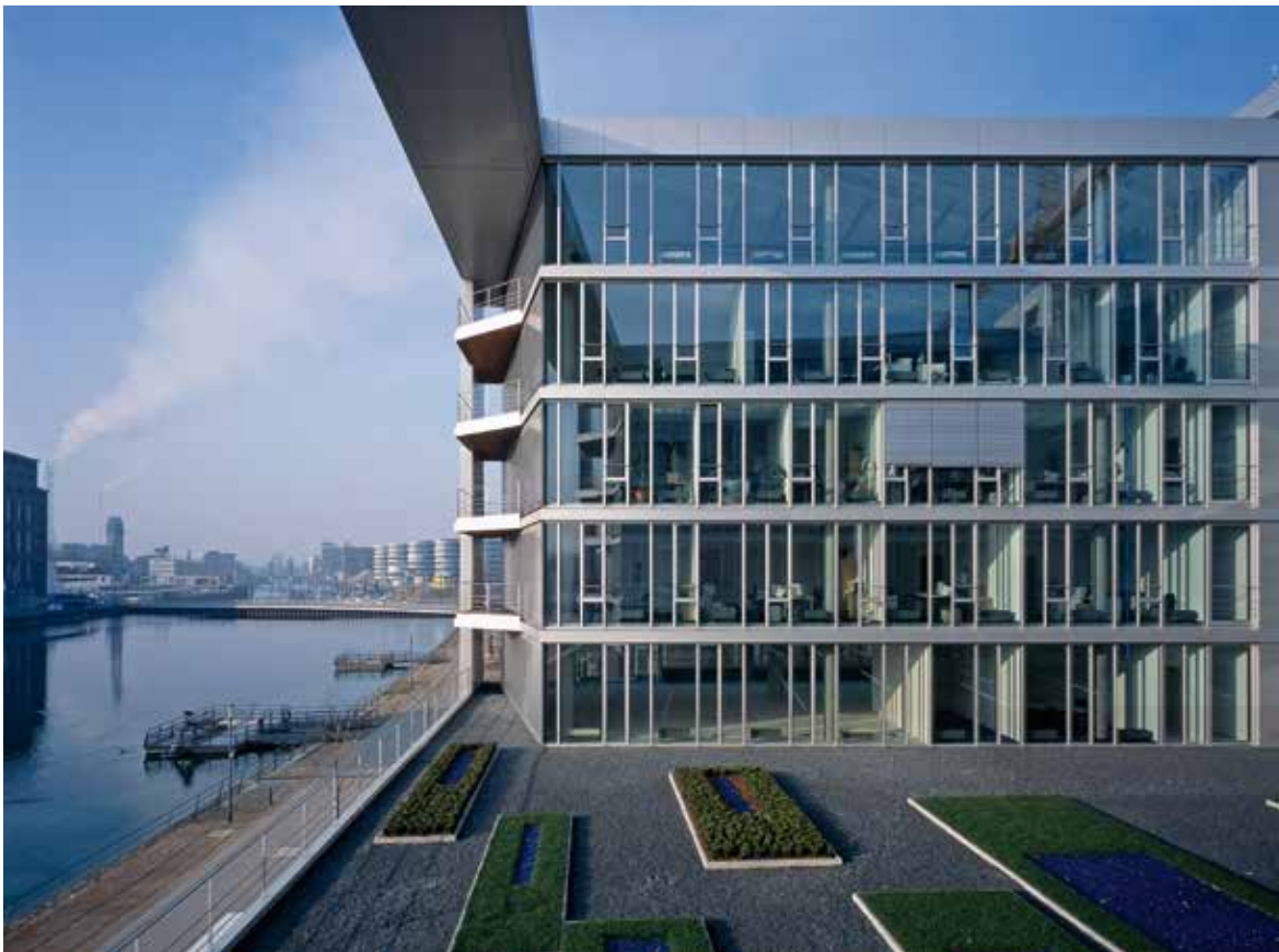
Unternehmenszentrale der Wirtschaftsbetriebe in Duisburg © WB Duisburg
