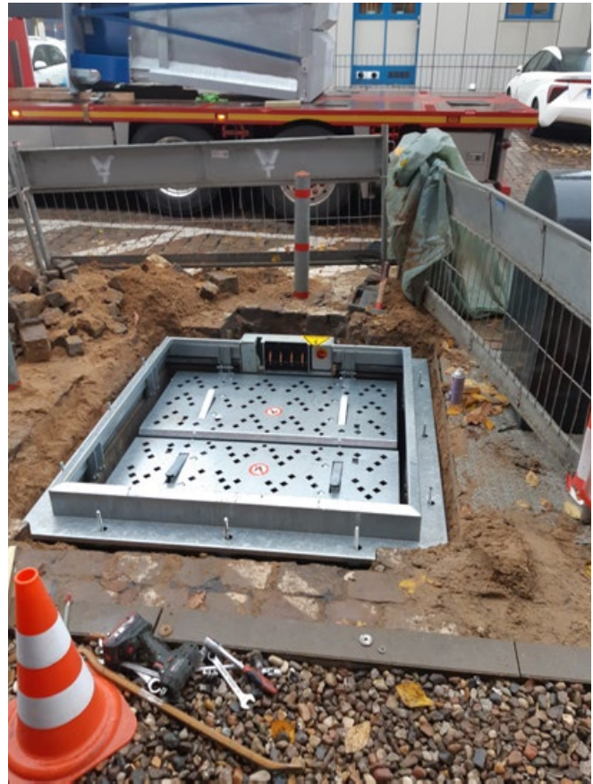
Einbau des Rahmens für Schneckenpresse mit Stromanschluss; Quelle: Stadtreinigung Hamburg (SRHH)
