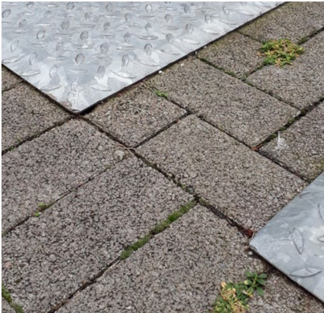
Gehwegplattform aufliegend; Quelle: Stadtreinigung Hamburg (SRHH)
