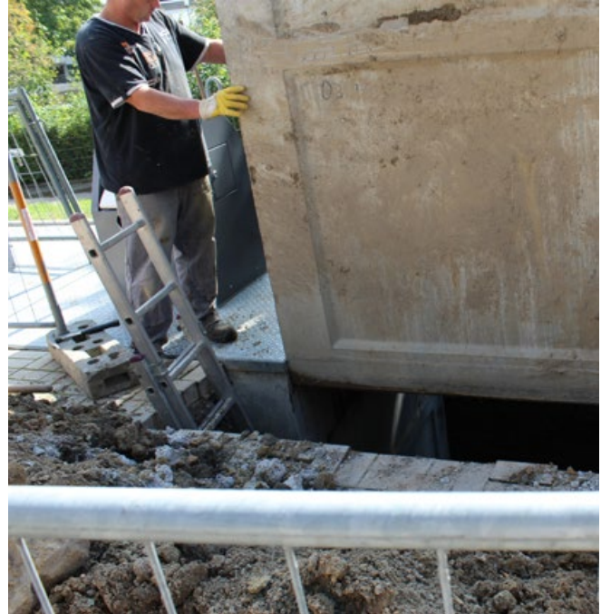
Ausbau der aufgetriebenen Behälter; Quelle: HEB Hagen
