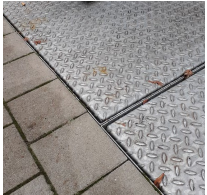
Gehwegplattform eingelassen; Quelle: Stadtreinigung Hamburg (SRHH)
