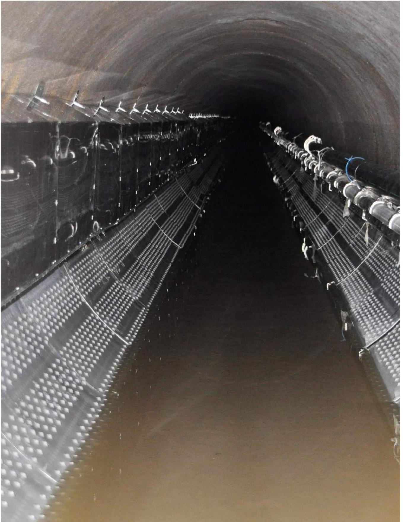
Abwasserwärmeprojekt des OÖWW am Alten Stadthafen: Blick in den Mischwasserkanal mit einem Durchmesser von 1,50 Meter.
